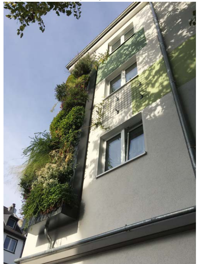
Wandgebundene Fassadenbegrünung an der Gladbecker Straße
